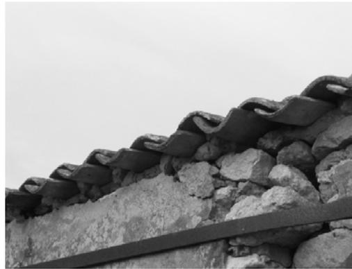
Couverture en tuiles canal sur voliges
