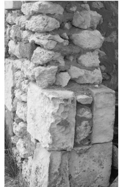
Deux parements de moellons avec blocage de petites pierres, de chaux Et de terre
